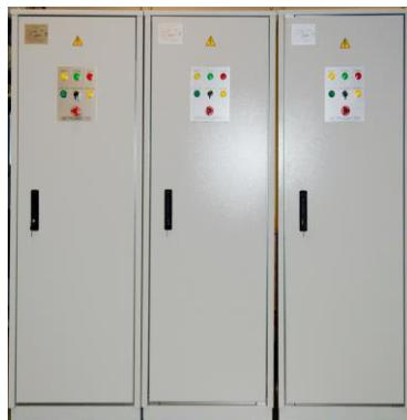
Шкафы управления противопожарные ШУП-630 предназначены для управления пожарными насосами, вентиляторами систем приточно-вытяжной противодымной вентиляции, задвижками с электроприводами.
